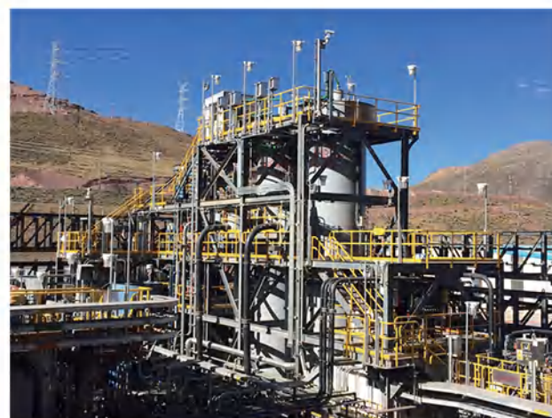
浮选柱应用于秘鲁特罗莫克项目 Flotation column running at Toromocho project, Peru
