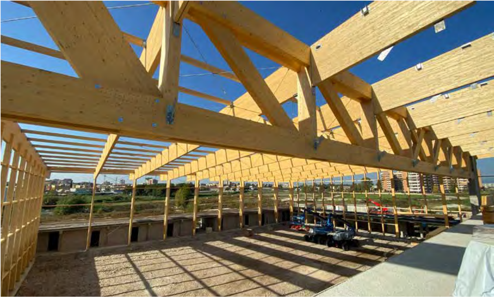
Palazzetto dello Sport di Aprilia, Latina. In fase di installazione Sport Stadium Aprilia, Latina. Work in progress
