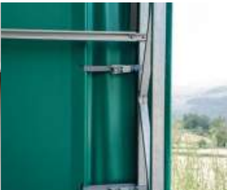
Tension des bâche avant Head tensioning cover
