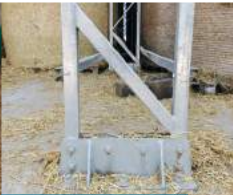
Anchorage sur base bétonnée Anchorage on slab
