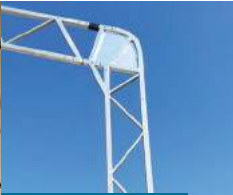
Structure en treillis Trellis structure
