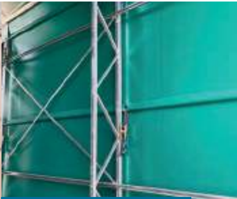
Structure en treillis Trellis structure
