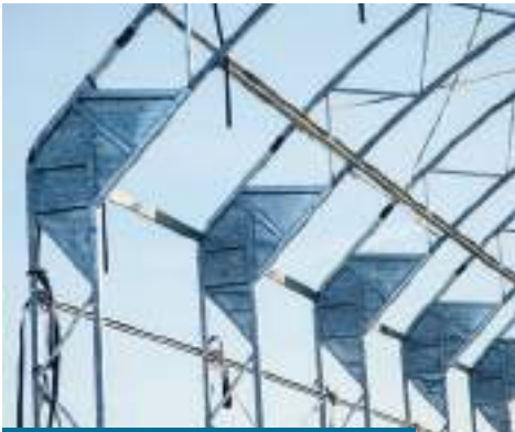
Renforcement sur les nœuds Reinforcement plate on the column-arch node
