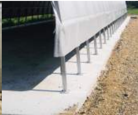
Ancrage sur base bétonnée Anchorage on slab
