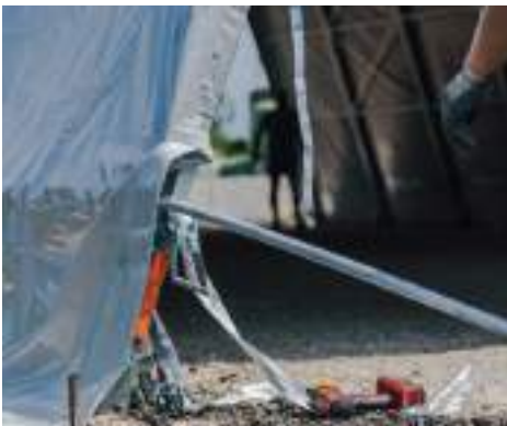
Tension des bâche latéraux Side tensioning cover
