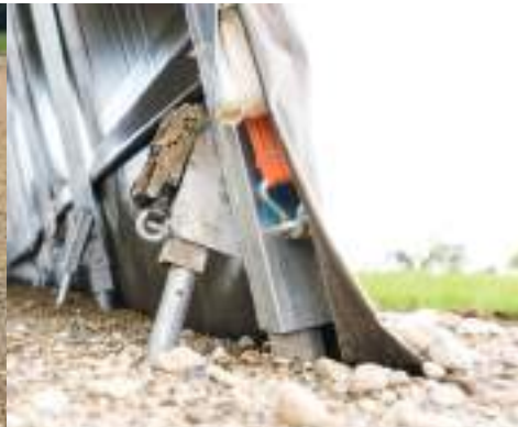
Ancrage avec double piquet Double picket
