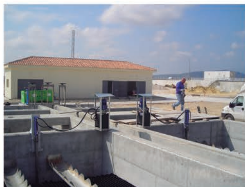
TRAITEMENT DE L'EAU POTABLE
